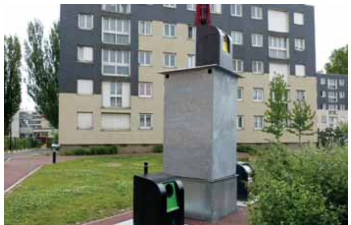
©syndicat emeraude / maintenance des bornes enterrées
