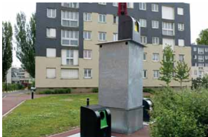
©syndicat emeraude / maintenance des bornes enterrées
